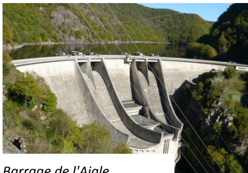
Barrage de l'Aigle
